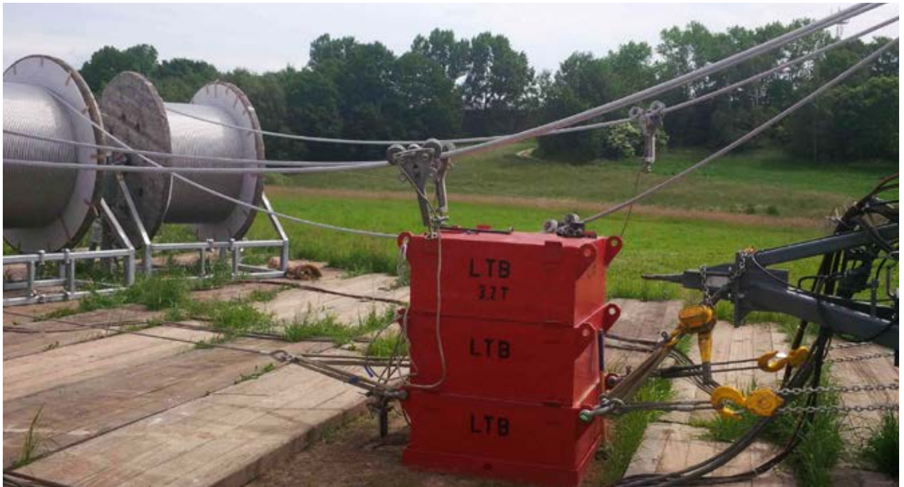
Abbildung 9: Örtlicher Potenzialausgleich am Trommelplatz, Quelle [5]
